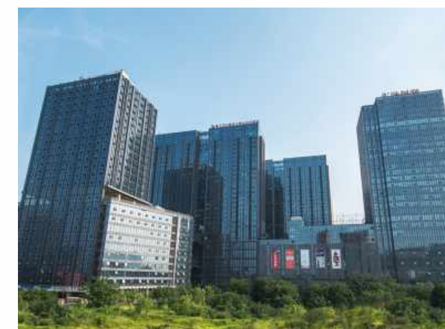
汇融广场（锦华）项目全貌
